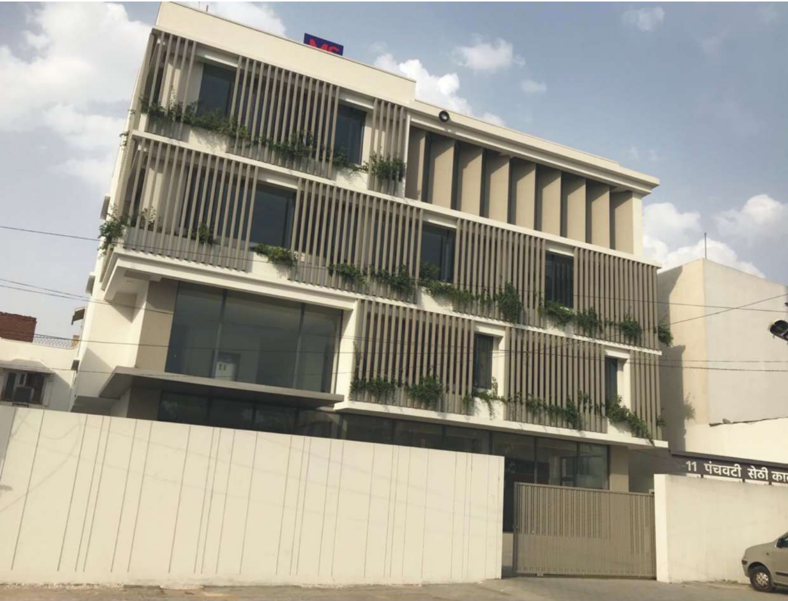
Actual on Site Picture
